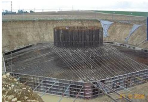
500 à 900 tonnes de béton
